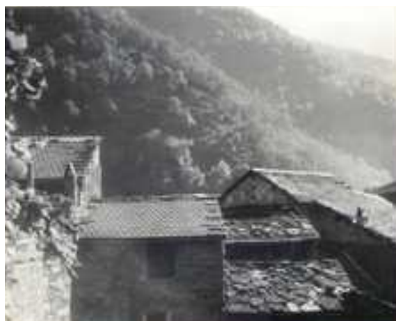
Tetti in laterizio e tetti in lastroni di ardesia.
