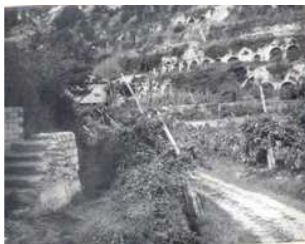
Muretti ad archetto per sostegno delle fasce.
